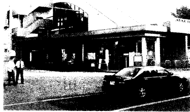
エレベーター設置が 予定されている 鎌ヶ谷大仏駅
