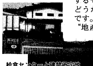
給食センターと建替予定地
